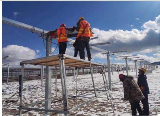
安装光伏支架
