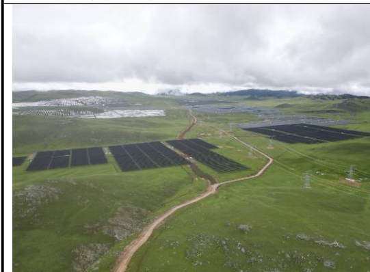
光伏阵列现状 2023. 07. 30
