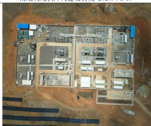
升压站建设现状 2023.04.19
