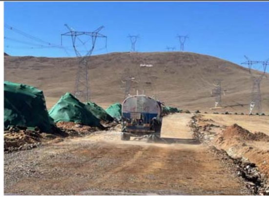
对道路工程剥离表土遮盖
