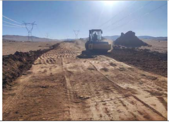
剥离迁建道路表土
