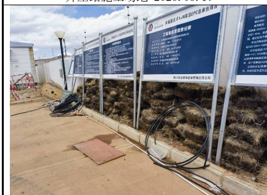
升压站剥离的草甸 2023.03.17
