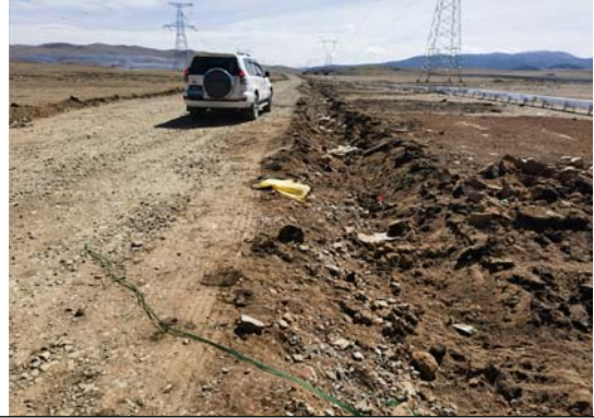
迁建道路排水沟
