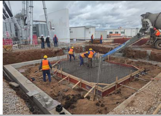
正在施工的主变基础
