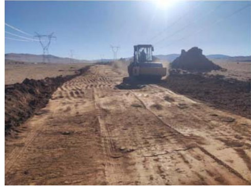
正在施工的迁建道路
