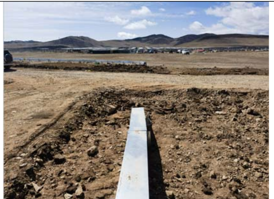
输电电缆穿越迁建道路
