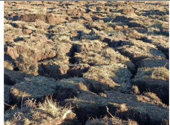
对原道路回铺草甸
