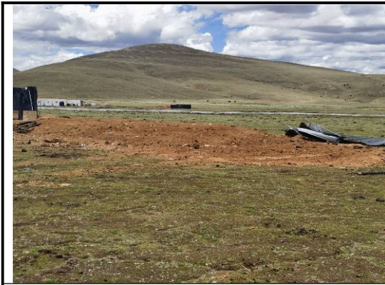
南地块施工场地土地整治 2023. 06. 30
