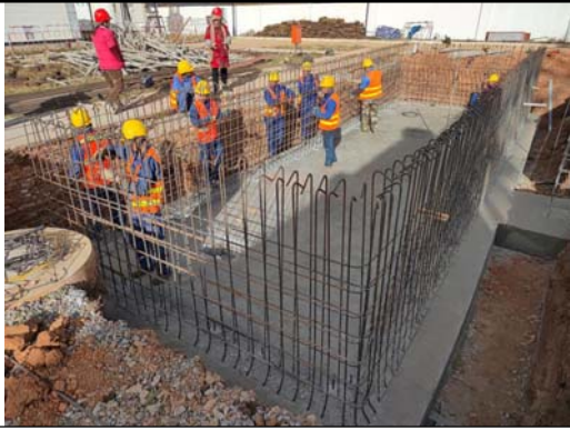
正在施工的 35kv 变电仓基础
