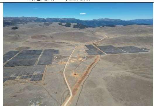
光伏阵列建设现状 2023. 05. 30
