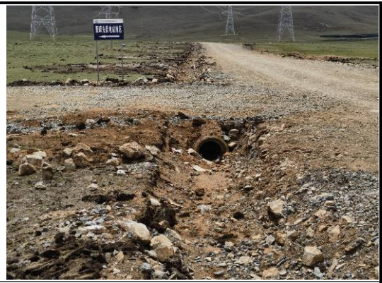
道路排水涵管 2023. 06. 30
