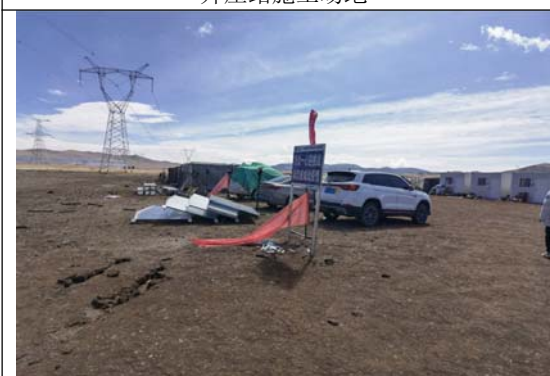
南地块施工场地
