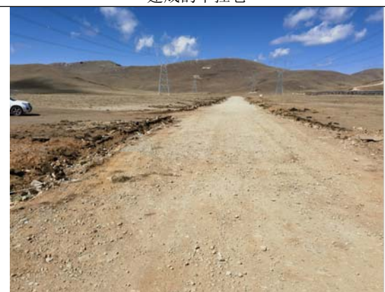
建成的迁建道路
