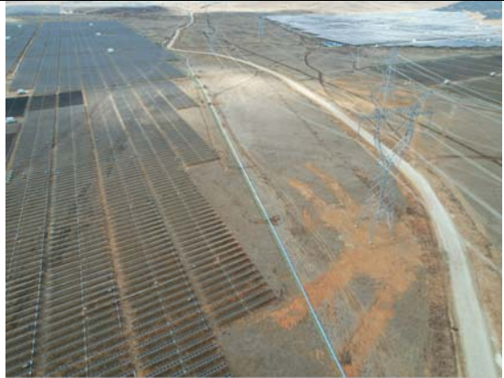
输电桥架建设现状
