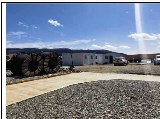
升压站施工场地 2023.03.17
