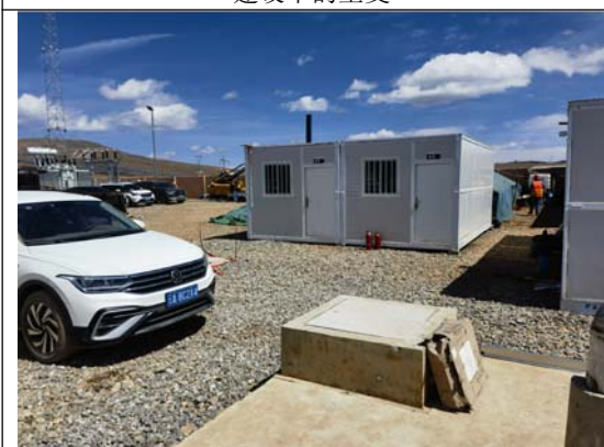
升压站施工场地
