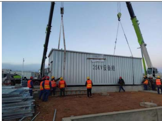
安装 35kv 变电仓
