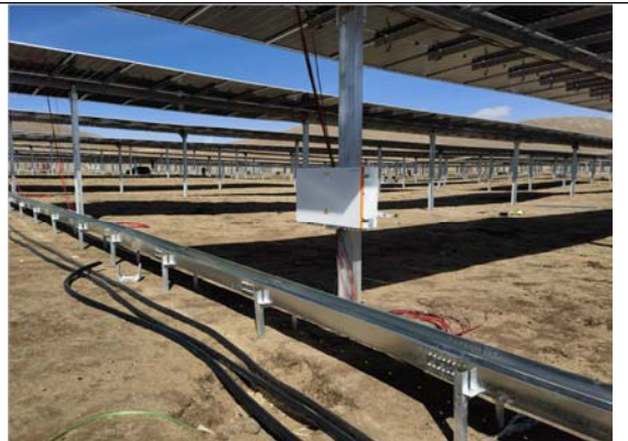
汇流箱建设现状
